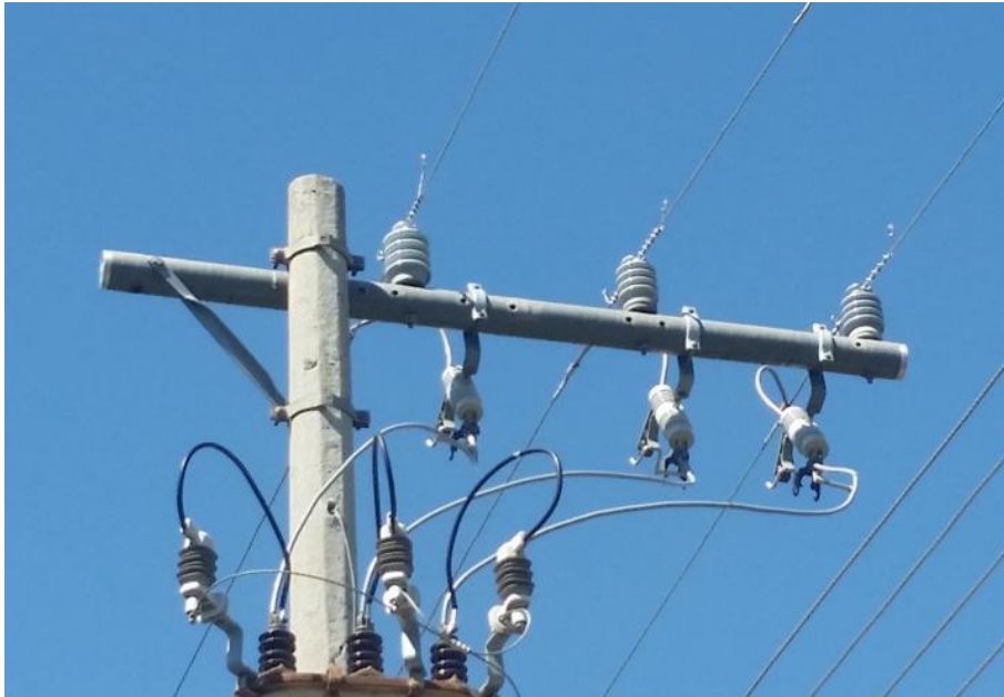
Fotos 12 – Instalação com cruzeta composta polimérica em rede urbana.
