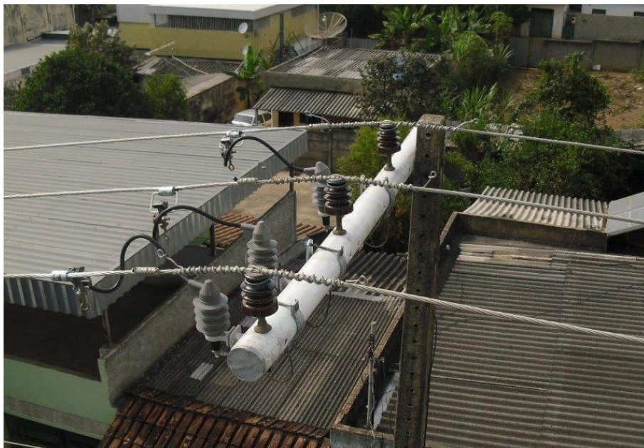
Fotos 13 – Instalação com cruzeta composta polimérica em rede urbana.
