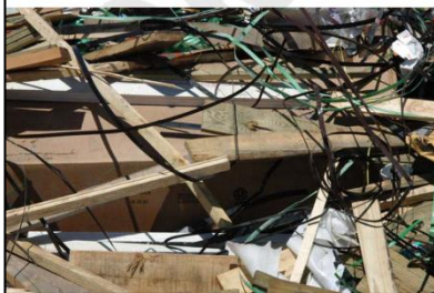
Depósito de descarte de material de construção
